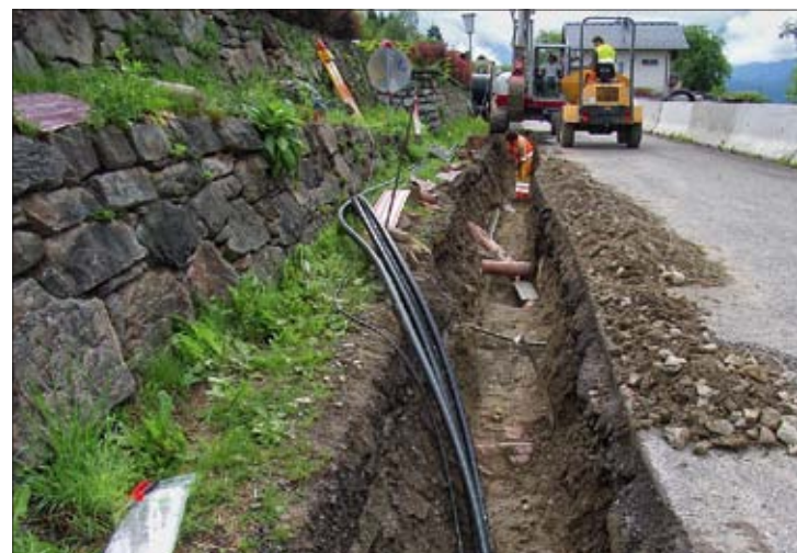
Verlegung Erdkabel der TIWAG
