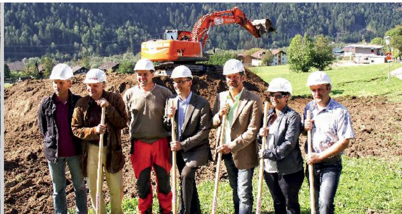
Spatenstich Wohnanlage Schneebergerfeld
