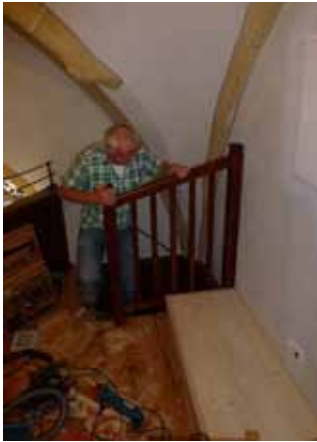
Josef Ortner montiert die Podeste und das Geländer.
