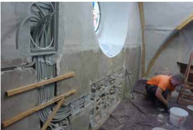
Die Elektroarbeiten führt Hannes Webhofer mit vielen Helfern durch. Georg Bruckner fertigt die Brüstungserhöhung an.
