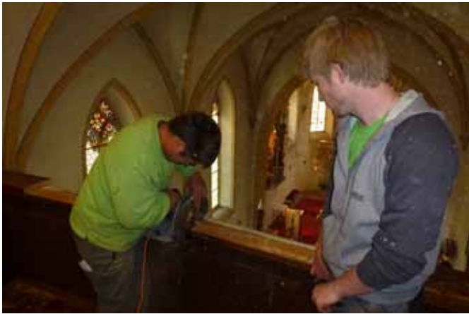
30.04.2014: Es geht los! Mitarbeiter der Fa. Holzbau Duregger schneiden die Brüstung auf, die alte Orgel verlässt dann ihren Platz.
