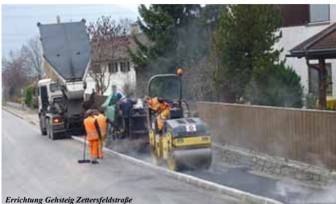
Errichtung Gehsteig Zettersfeldstraße
