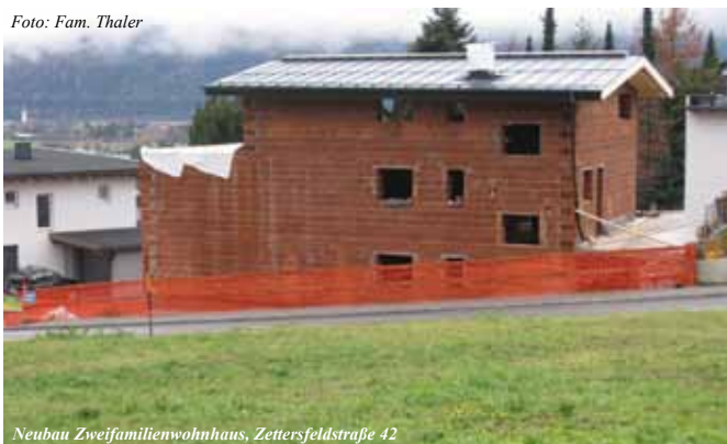
Neubau Zweifamilienwohnhaus, Zettersfeldstraße 42
