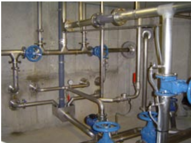
Verteilersystem Entsäuerungsanlage
