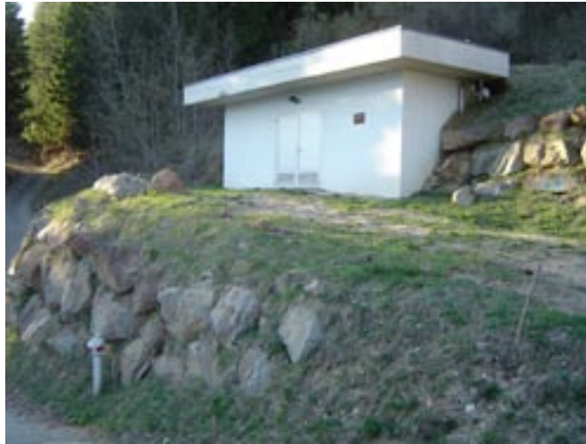
Hochbehälter 1 – 1.080 m Seehöhe
