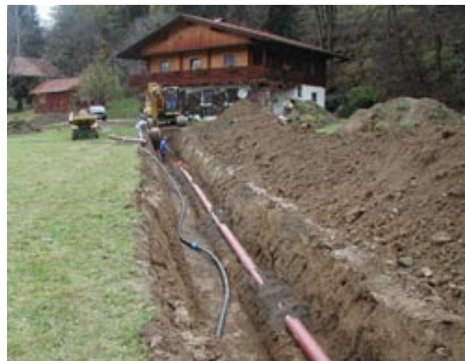
Rohrverlegungsarbeiten WVA Wartschensiedlung
