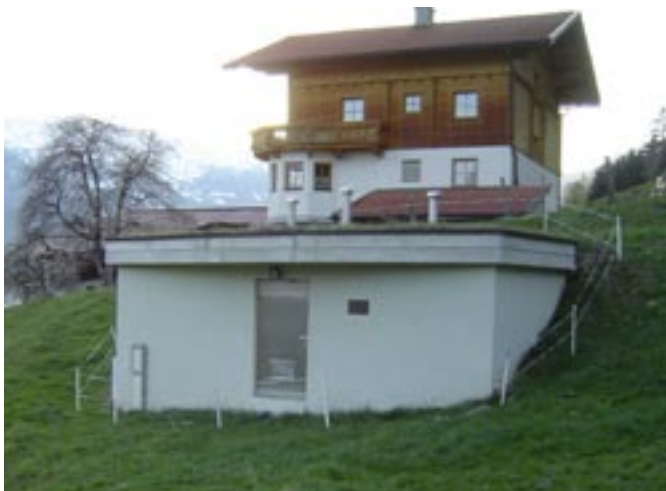
Hochbehälter 2 – 865 m Seehöhe
