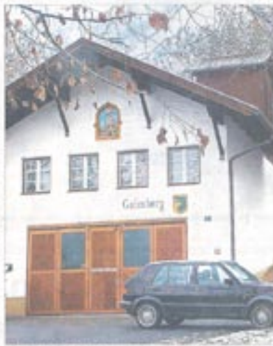
Das 1996 entfallene Feuerwehrhaus wird abgerissen.
