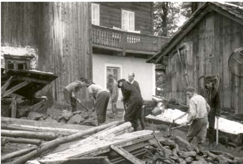
Die Gaimberger Feuerwehr bei Aufräumungsarbeiten beim „Kontriner“
