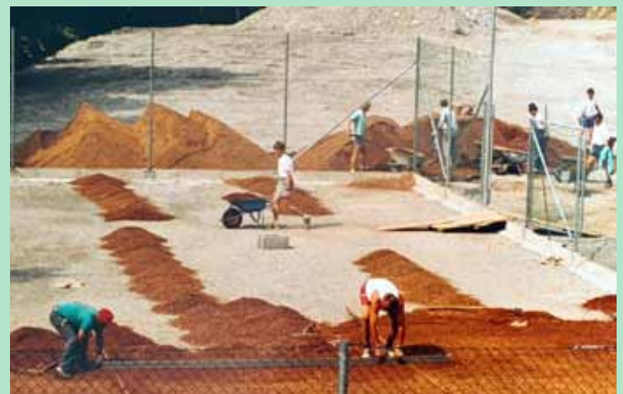
Neubau des Tennisplatzes.
