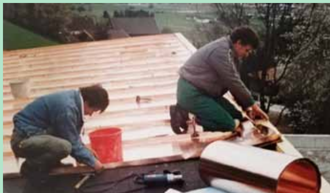
Spenglerarbeiten im April 1994.
