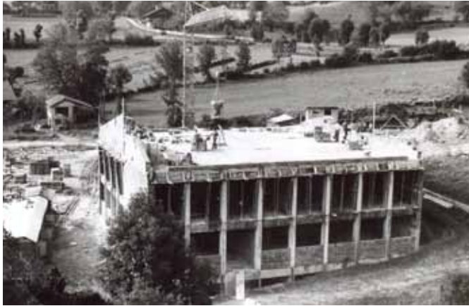
Ein besonderer Bauabschnitt: Der First wird gemauert!
