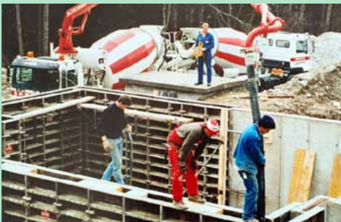
Schalungsarbeiten für das neue Vereinsheim.
