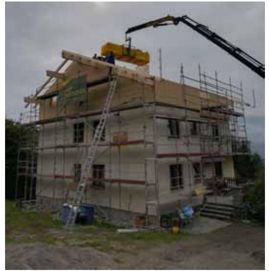
Um- und Zubau Wohnhaus (Obergaimberg 9)
