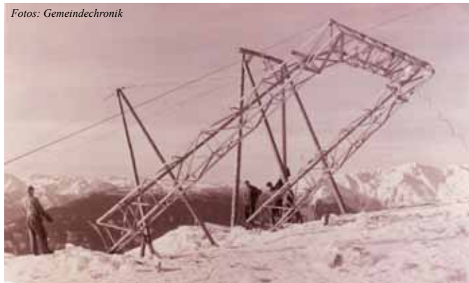
Der Schlepplift im Bau.
