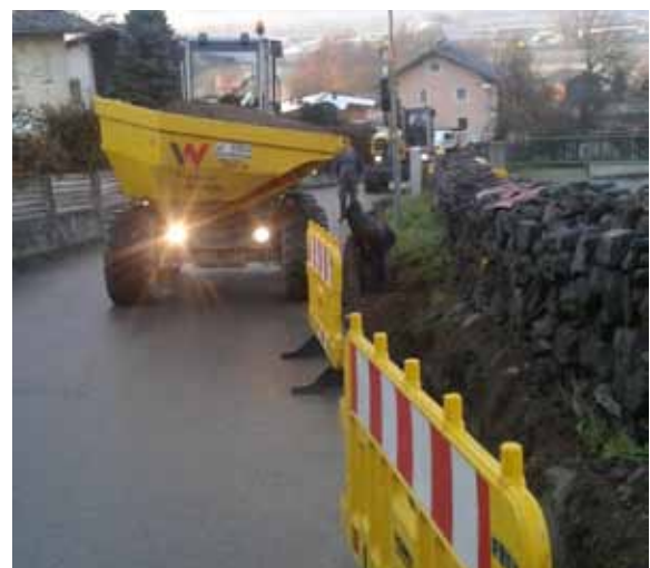
Grabungsarbeiten für Breitbandinternet „RegioNet Gaimberg“ in der Wartschensiedlung.
