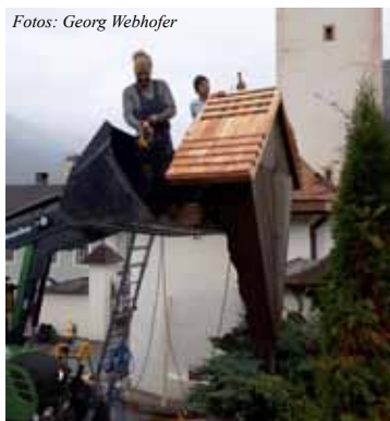
Florian Unterweger (links) und Peter Ortner haben das Dach des Kreuzes „geschindelt“.
