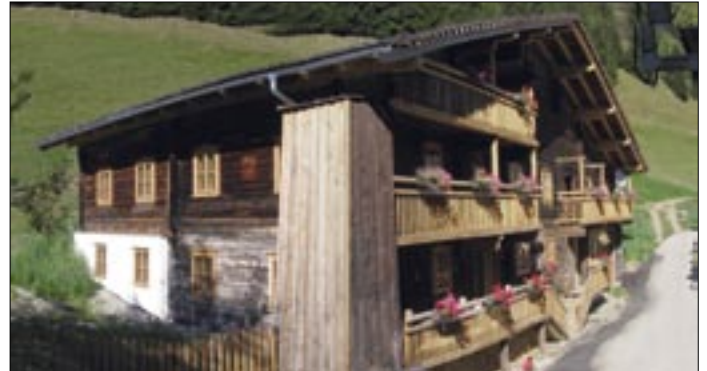
Sanierung des Bauernhauses „Trogach“ in St. Jakob i.D.
