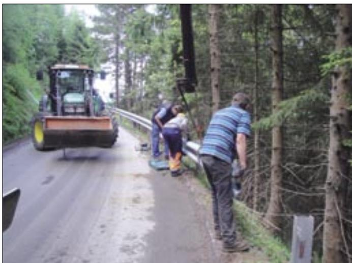
Weiters wurden neue Leitschienen im Mühlwald und im Bereich der Splitthütte errichtet. Fehlerhafte Leitschienen, verankerte Lärchenbäume und schlechte Bankette sowie der Asphalt wurden auf der gesamten Straße saniert. Alle Arbeiten wurden wieder als Eigenregiebaustelle mit Mitarbeitern von Agrar Lienz und Gemeindemitarbeitern zu unserer vollsten Zufriedenheit durchgeführt.
