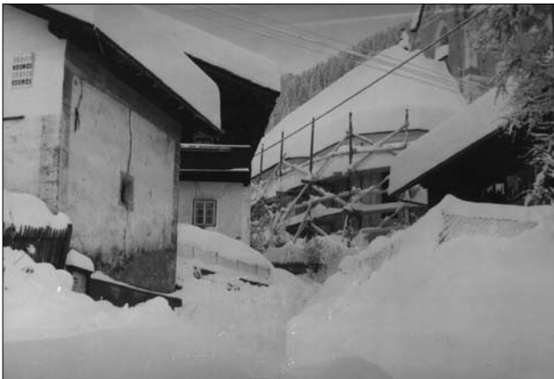
1974: Viel Schnee im März. Mit der Renovierung der Kirche war schon begonnen worden. Links der Weber Kornkasten, rechts das Schneiderle Haus. Die Engstelle zwischen Kirche und Schneiderle wird noch im Laufe des Jahres erweitert (siehe Bilder rechts).
