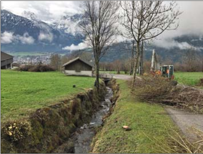
Entfernung Bewuchs entlang des Zauchenbaches. Foto: Reinhold Kollnig
