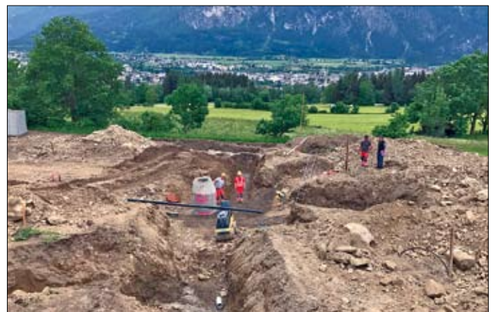
Erschließung Mußhauserfeld mit Kanal, Wasserleitung, Lichtwellenleiter, Strom, Straßenbeleuchtung und Oberflächenentwässerung.
