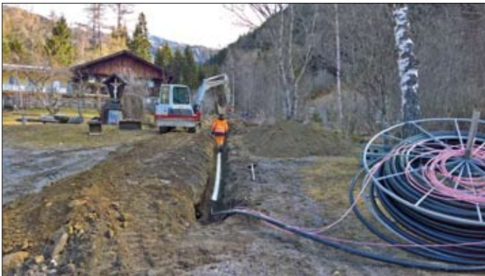
Verlegung LWL in der Prappernitze.
