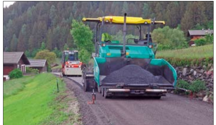
Asphaltierung der neu sanierten Straße in der Prappernitze.
