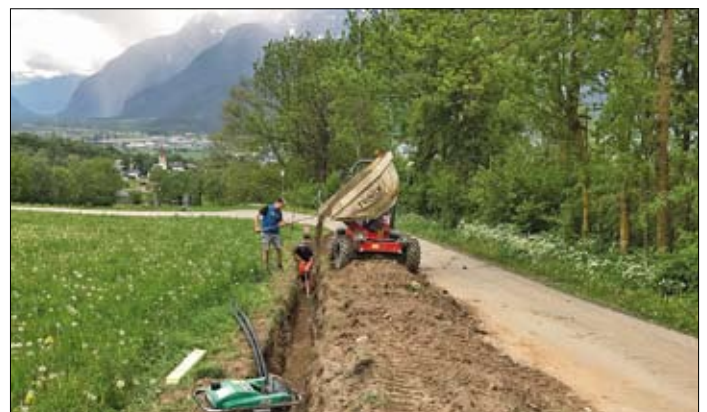
Erschließung der Lampitze mit Lichtwellenleiter.
