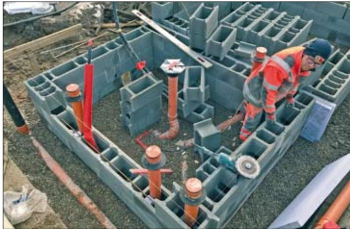
**November.** Errichtung des Fundamentes, der Frostschürze und der Versorgungsleitungen für das Buswartehäuschen mit öffentlichem WC.
