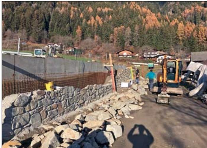
**Dezember.** Errichtung der südlichen Zyklopenmauer (Natursteinmauer in Beton verlegt).
