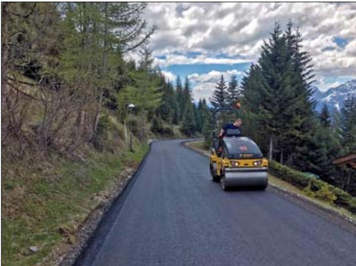
Eine 8 cm dicke Asphalttschicht wurde aufgetragen.
