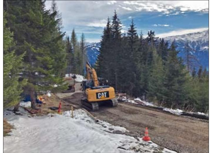
Im Bereich der Wochenendhütten und im Bereich vom Luxegg wurde der gesamte Unterbau der Straße entfernt und nach dem heutigen Stand der Technik neu aufgebaut. Talseitige Sicherung des Straßenkörpers durch den Einbau von bewehrter Erde mit Armierung (Geotextil).
