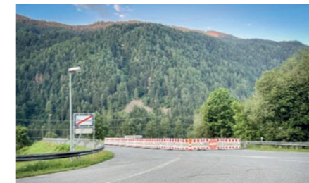
▲ Die Umfahrung Oberlienz wurde gesperrt.
