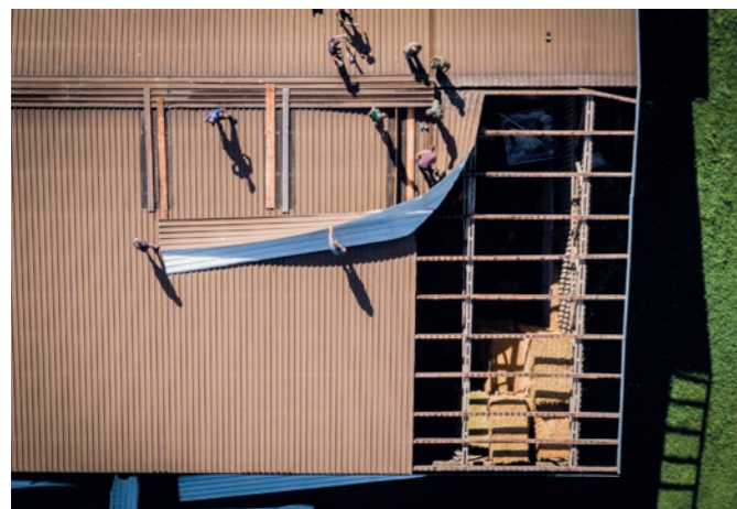
▲ Abgedecktes Dach Pöllander – Aufnahme mit Drohne
