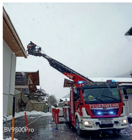
▲ Drohender Dacheinsturz – Vorstadt Ost, Drehleiter Lienz
